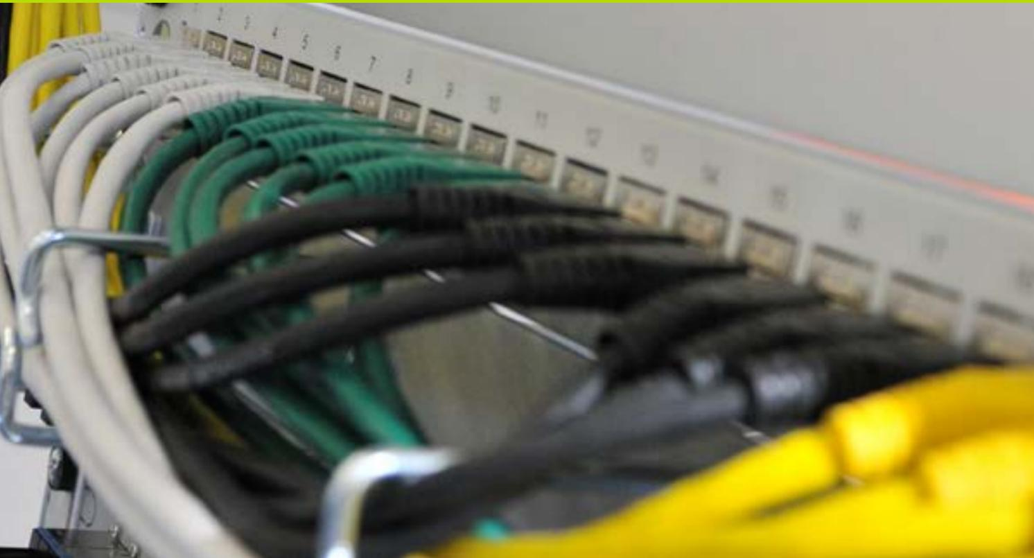
Die NETTEC solution profiliert sich durch ihr breites Verkabelungssortiment vom Kabel bis zur Dose für unterschiedliche UKV-Systeme. Wir bieten Module der Kategorien 5<sub>E</sub> bis 6<sub>A</sub> als geschirmte oder ungeschirmte Ausführung an.
